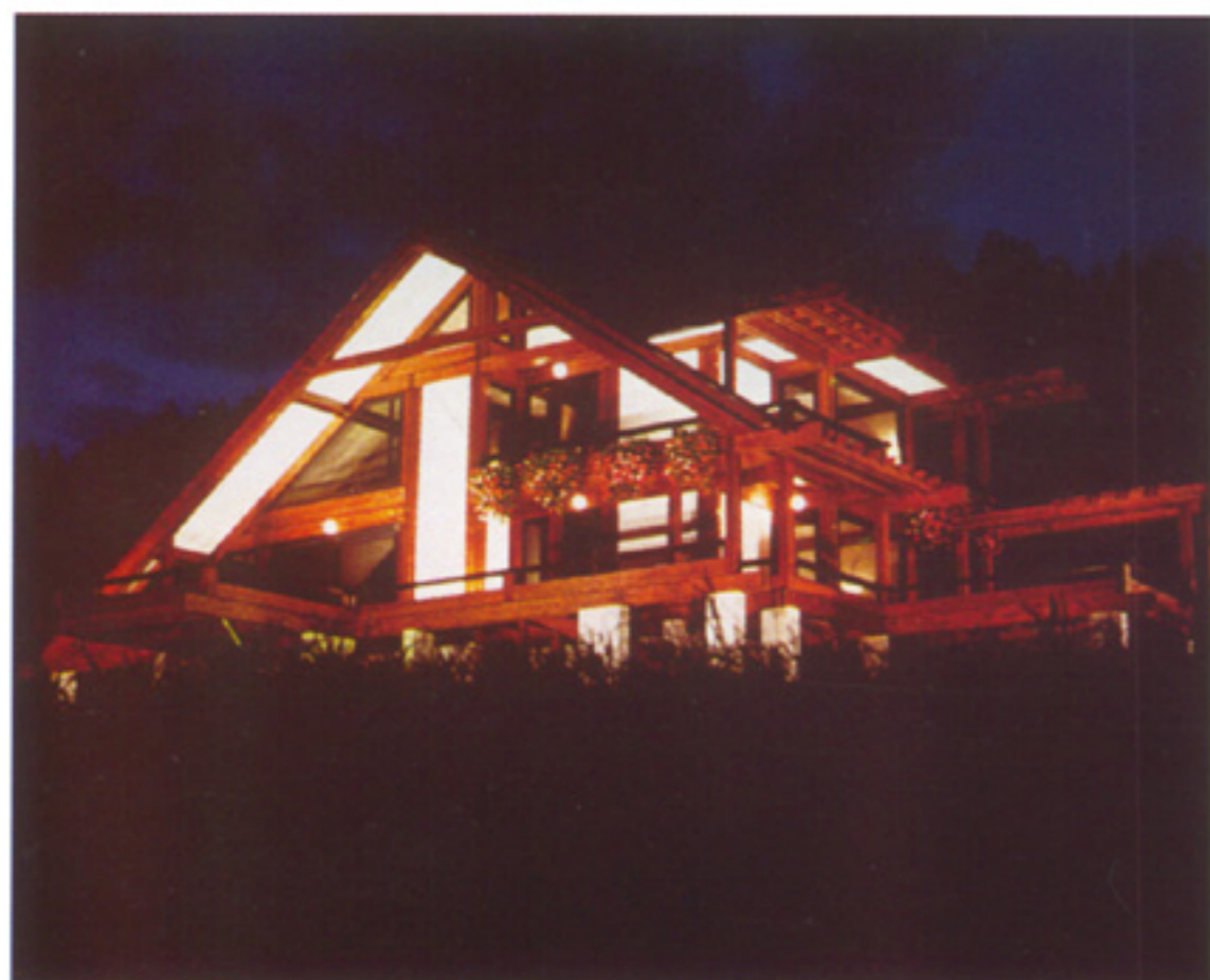
Capanno ecologico, unità abitativa ecologica completamente autosufficiente realizzata in legno lamellare; disponibile in modelli da 35 mq a 100 mq ottiene in tempi rapidissimi soluzioni con forte integrazione nel paesaggio, Pagano System. Ecological shed; ecological, self-sufficient housing unit in foliated wood; available in the 35 square metre and 100 square metre versions and offering rapid solutions which blend into the landscape, Pagano System.
