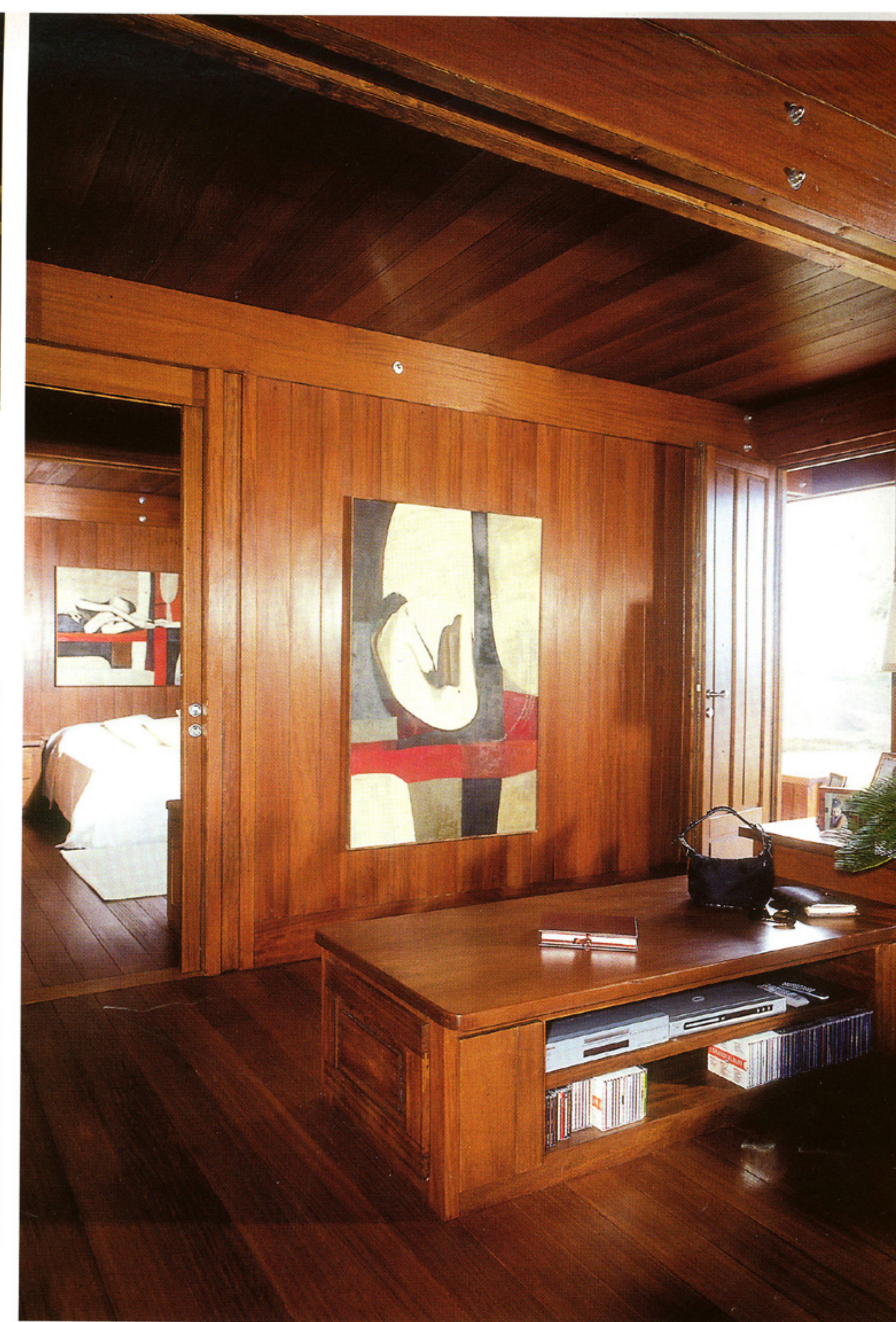
A sinistra, vista della camera da letto; gli arredi, fissi, sono stati progettati dalla Pagano System usando le stesse essenze lignee impiegate per gli elementi strutturali. In alto, dettaglio dello studio, completamente rivestito in legno.
